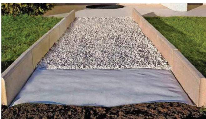
Pose d'un feutre géotextile recouvert de gravier avec bordures délimitant le gazon
