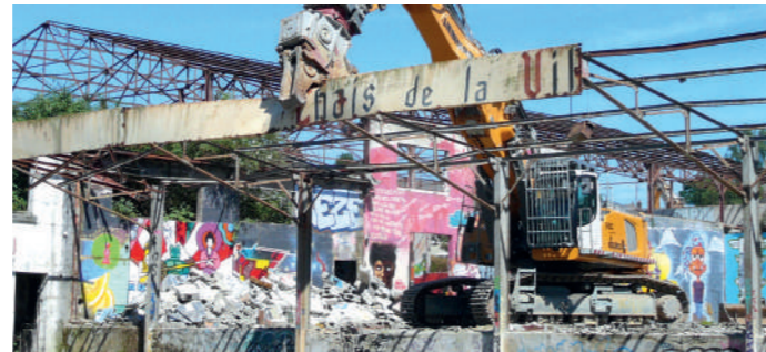
Démolition de la friche : la récupération de 11 000 m 2 en cœur de bourg permettant le développement d'une nouvelle aire d'habitat
