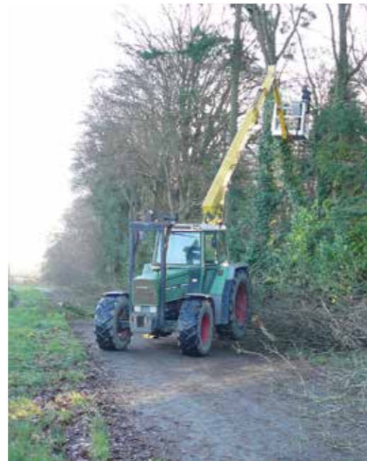
Elagage par Etar environnement des abords de la ligne de départ
