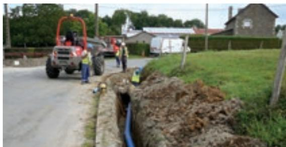
A la suite des travaux effectués en 2016 de Trébéfour à la Ménardière, le Syndicat des Frémur a fait changer par CISE.TP la conduite jusqu'à la Mairie. Le réseau AEP de la rue du Général de Gaulle au carrefour de Cana-Houillard en passant par le Pigeon Blanc, a été remplacé par une conduite fonte de diamètre 160 mm. Ce diamètre imposant permettra, la desserte des mai-
