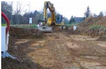
Au vu de la nature du sous-sol, un imposant empierrement de la voirie a été nécessaire. Cet enrochement mis en place sur un géotextile, assure une garantie de la structure de la chaussée. Dès que les conditions climatiques seront favorables, l'entreprise de travaux publics Lemée effectuera un bi-couche goudronné, favorisant ainsi l'étanchéité de la voie. Le maître d'œuvre URBA'REAL a eu l'assurance par la société ERS que, dans la foulée des tra-
